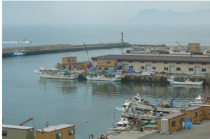
岸壁に2階建のスーパーハウスが建ち並ぶ虻田漁港
