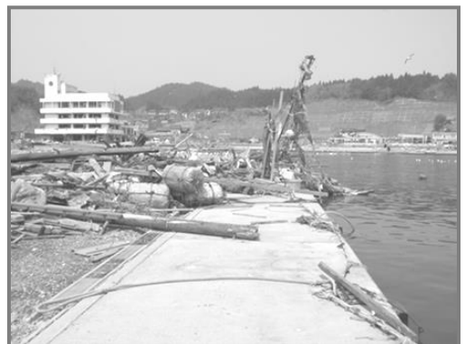
写真4 気仙町地区の被災状況
